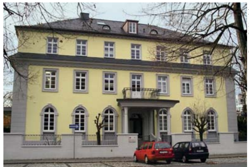
Die preisgekrönte Fassade des Noviziats in Nürnberg
